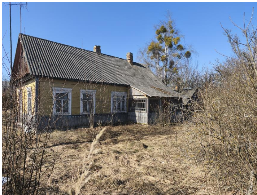
д. Вяз, ул. Центральная, д. 19
