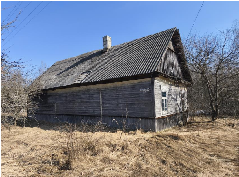
д.Вяз, ул. Центральная, д. 66
