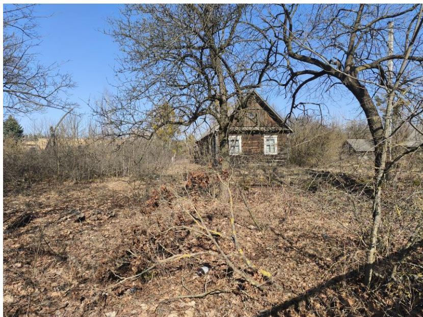
д. Вяз, ул. Центральная, д. 17
