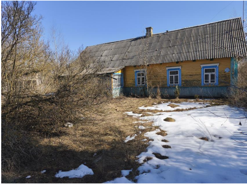
д.Вяз, ул. Центральная, д. 14
